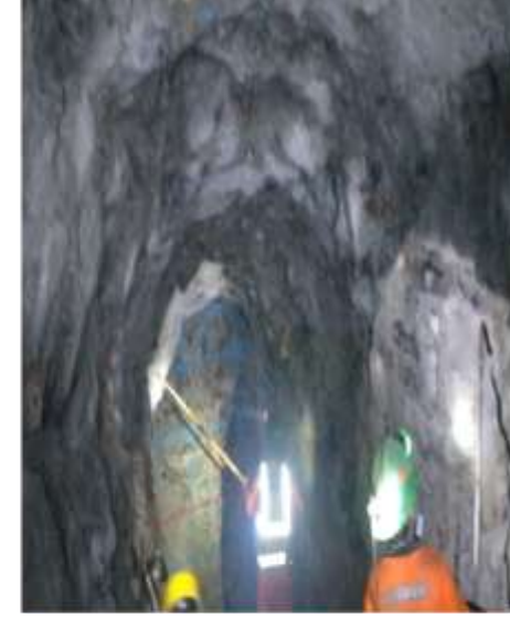
AVANCE JACKLEG CHIMENEA 2.4 X 1.2 M
