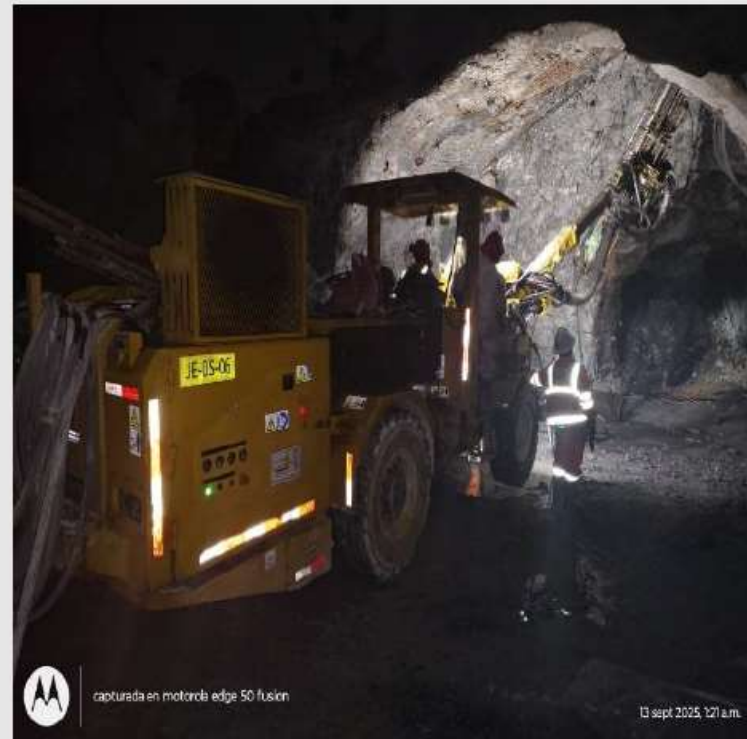
SOSTENIMIENTO CON BOLTER SECCION 4.0 X 4.0 M
