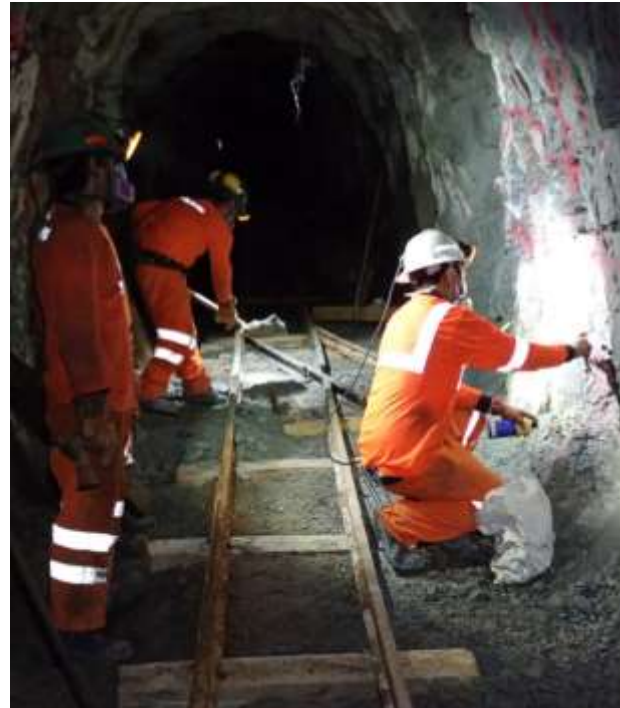
INSTALACIONES CAMBIOS EN EXCAVACIONES HORIZONTALES
