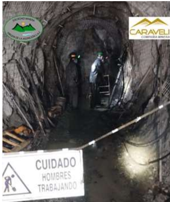
EXCAVACIONES HORIZONTALES CONVENCIONAL
