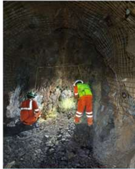
SOSTENIMIENTO CON PERNOS Y MALLA
