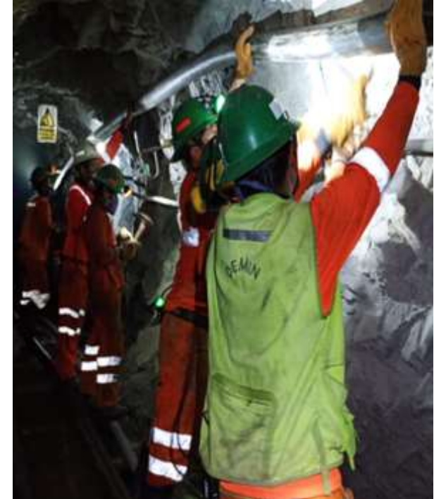
TRABAJOS DE SERVICIOS INSTALACIONES DE TUBERIAS
