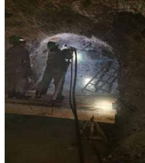
AVANCE HORIZONTAL CON MAQUINA JACKLEG BP 700 Nv. 1700
