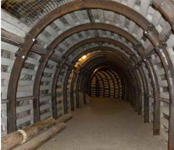
AVANCE XC 450 W CON SOSTENIMIENTO DE CIMBRAS 3.5 x 3.50. Nv 1700
