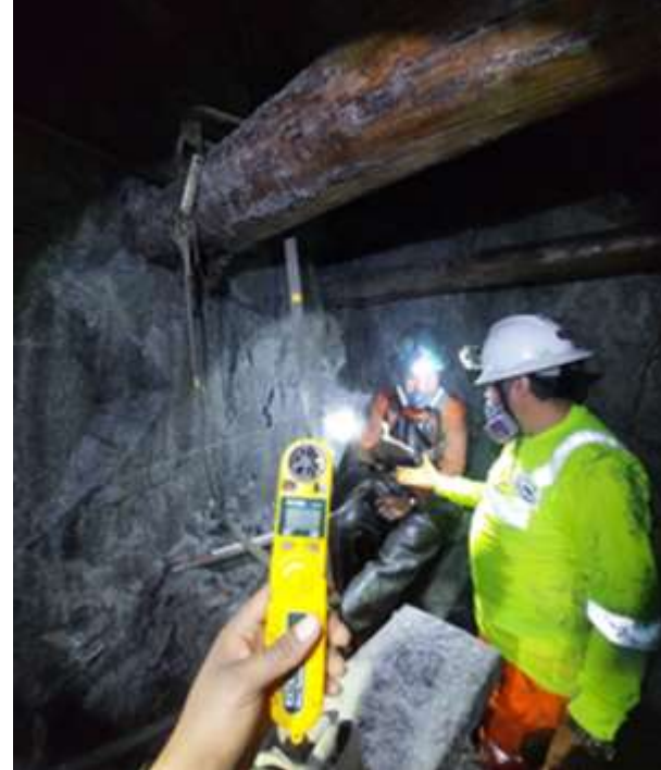
MONITOREO DE GASES EN EXCAVACIONES VERTICALES
