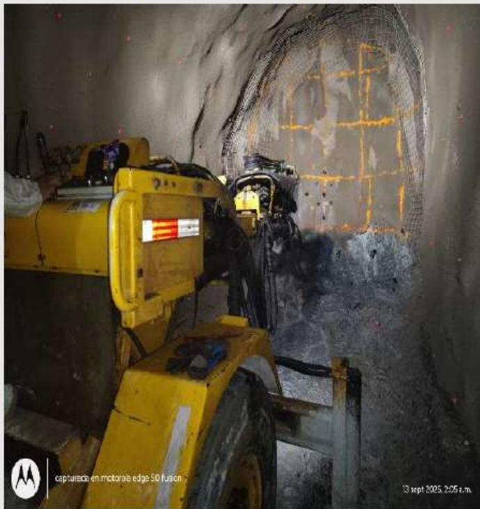
PERFORACION CON JUMBO SECCION 3.5 X 3.5 M
