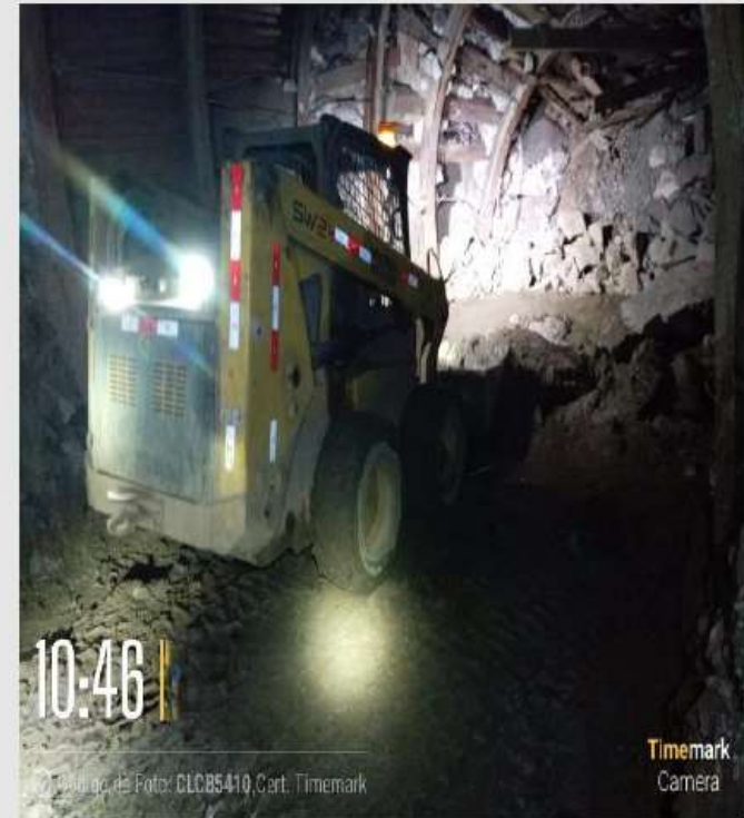
LIMPIEZA CON MINICARGADOR SECCION 2.0 x 2.0 M
